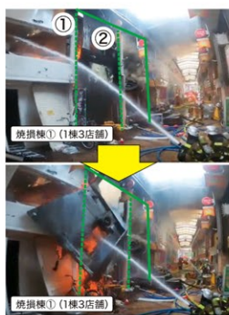
崩落した時の状況
