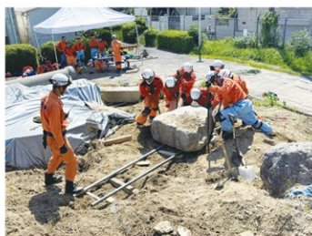
能登半島地震で課題となった重量物の除去(ムービング)を取り入れた訓練を実施(令和6年9月、高度専門教育訓練センターにて)
