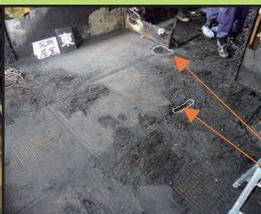
※出火箇所が畳の場合は特に**焼け込み**に注意して**床部分を見分**しながら、焼け込み箇所を探すこと。印で明示して撮影すると分かりやすい。
