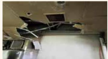
写真2：飛散したボンベで破壊された天井
