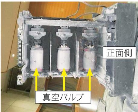
写真2 真空遮断器(下面・右端がバルブA)
