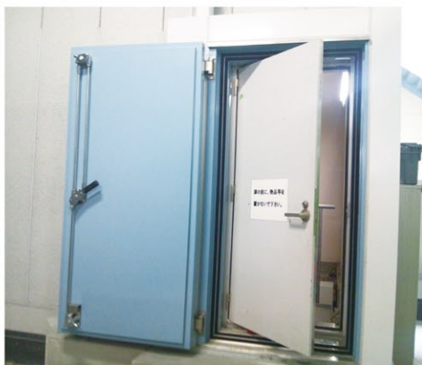
写真5 受水槽室防水扉
