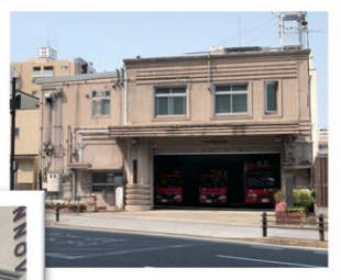
*令和3年8月までの元町出張所旧庁舎外観
