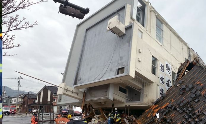
1月3日 ビル倒壊隣接木造建物での救出活動(河井町)
