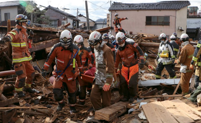
1月5日 木造倒壊建物での救出活動(河井町)
