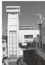
庁舎南側から高さ23.8メートルの望楼を望む
