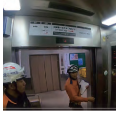
非常用エレベーター
