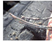
溶融痕・・・電気配線が溶融した痕 電気痕・・・電氣的要因により電気配線が溶融した痕
