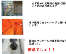
仮設トイレ設置方法
