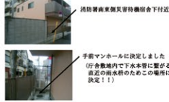
東住吉消防署の仮設トイレ設置場所
