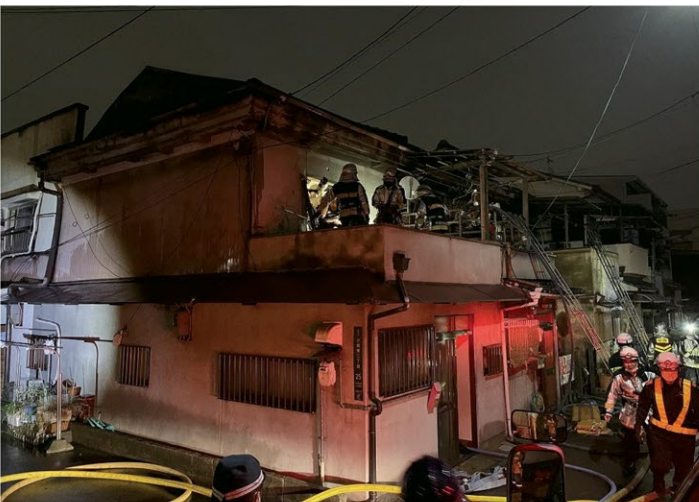
南面の状況 (南西側から撮影)
