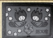
◆会場内の消火栓の鉄蓋
