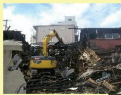
▲重機による崩落危険除去
