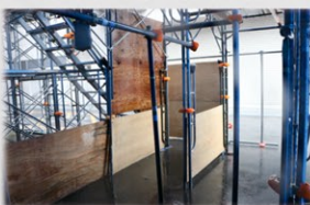
木造文化住宅を想定した 模擬家屋訓練塔施設
