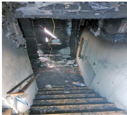
階段室の状況
